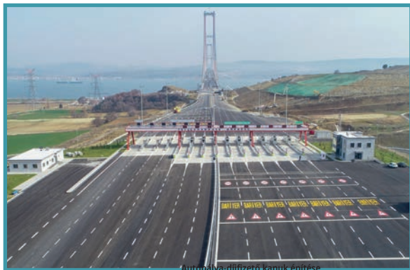
Autópálya-díjtető kapuk építése
